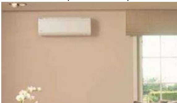
Indoor Ductless Mini Split Head
